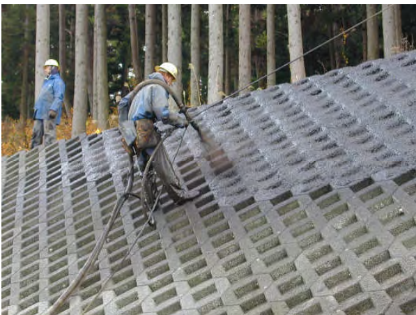
ポーラスコンクリートのり面 吹付状況
