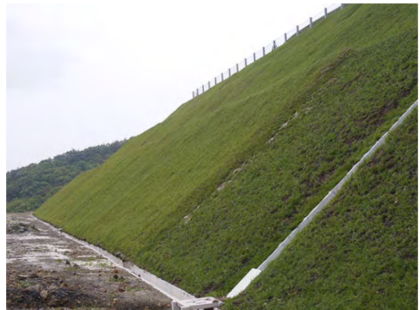
のり面緑化完了
