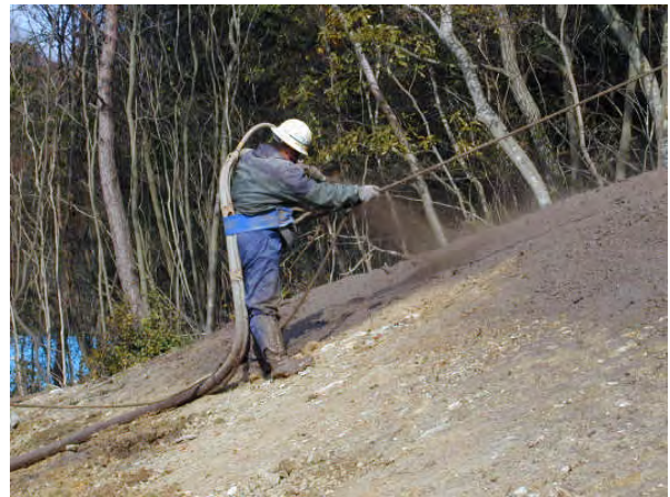
のり面 吹付状況
