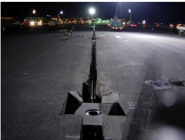
空港滑走路 誘導灯改修
