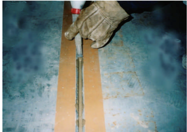
PC版目地材充填状況
