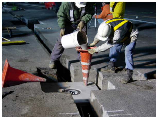
PFG-01 充填状況
