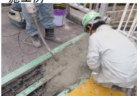
道路橋伸縮継手(コンクリート)
