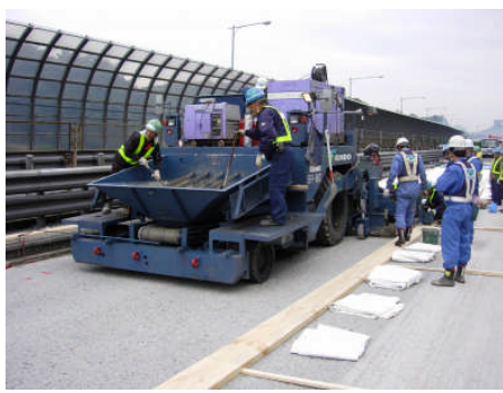
写真 2 床版増厚施工状況
