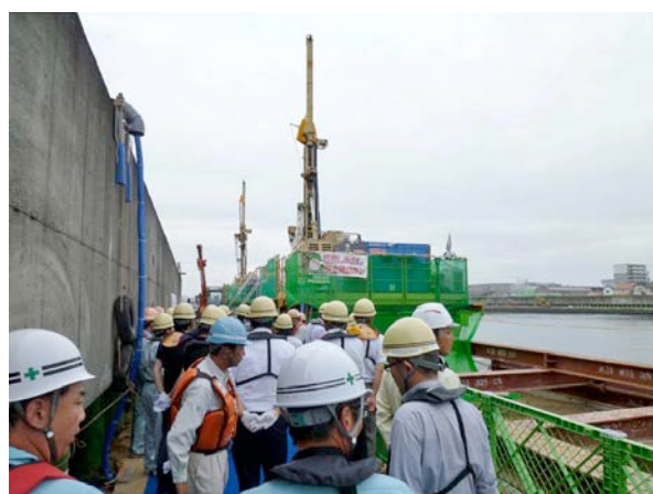
施工状況見学
