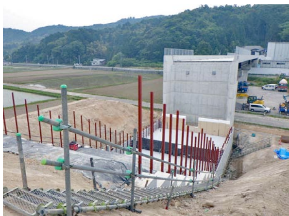
気泡軽量盛土工法 (FCB 工法) 施工状況
