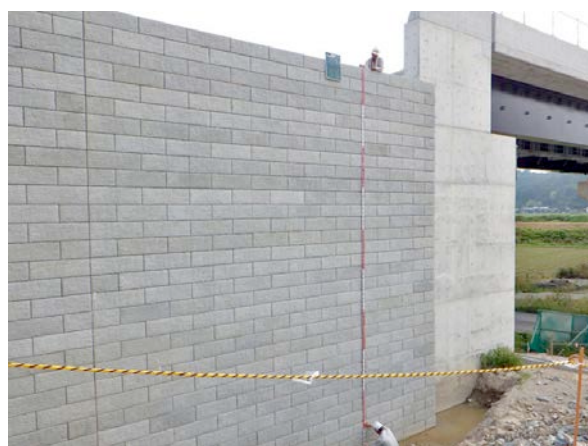
気泡軽量盛土工法 (FCB 工法) 施工状況
