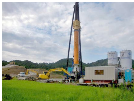
地盤改良(EPO-Loto 工法)施工状況
